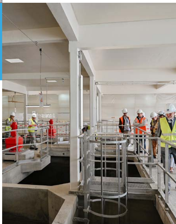
Rénovation des décanteurs
