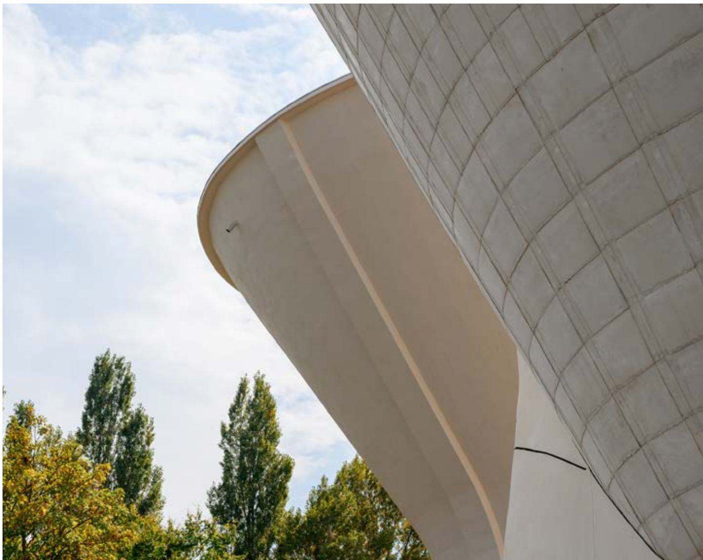
À gauche, le réservoir réhabilité, à droite, le nouveau réservoir.
