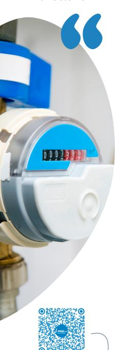
Les faibles températures impactent vos installations d'eau: en dessous de zéro degré, le compteur d'eau et les canalisations risquent de geler. En gelant, l'eau présente dans les tuyaux risque de les fissurer ou de les casser. Le gel peut alors endommager le compteur. Or, celui-ci relève de votre responsabilité: s'il est endommagé, des frais de réparation vous seront facturés.
