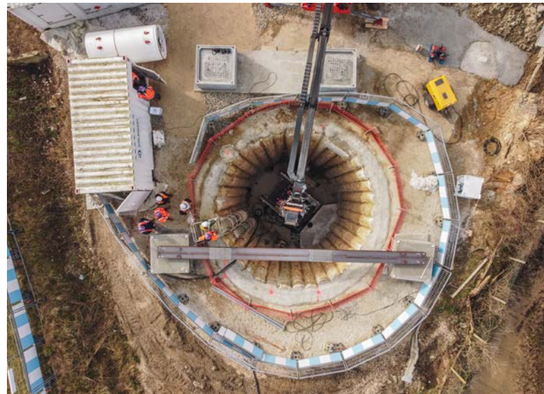
Le puits d'introduction du micro-tunnelier.
