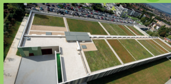
Toiture terrasse végétalisée du réservoir R7 de Villejuif
